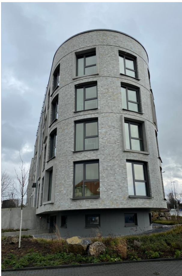
Bild 1 -3: Wohngebäude mit Tiefgarage. Ableitungen hinter der Klinkerfassade verlegt. Erdreich-Erdungspunkte in den Kiesstreifen und in den Beeten erstellt.
